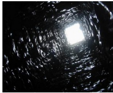
Slika 16; Katranske obloge v dimniku kot posledica zelo slabega zgorevanja zaradi vlažnih drv in nepravilnega kurjenja
